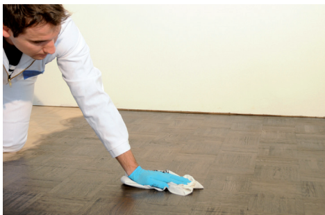
ODSTRÁNENIE PREBYTKU OLEJA
