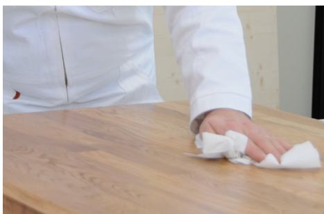
ODSTRÁNENIE PREBYTKU OLEJA
